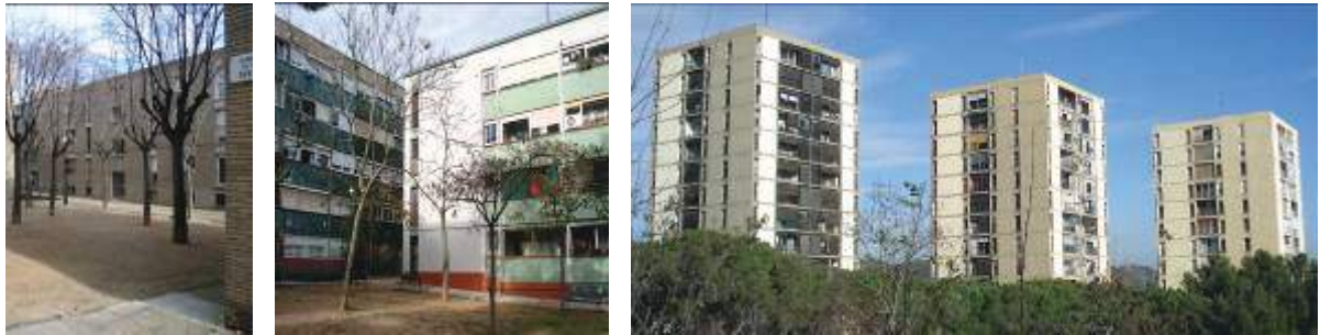
Figura 7 - Fotografías de los bloques P, R y las torres Q
