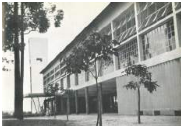
Figura 7: Vista del acceso con el depósito de agua al fondo
