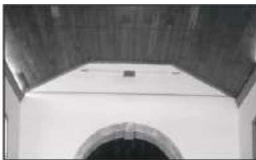
Fig.05. Forro em gamela com tabuado de madeira do tipo “saia e camisa”
