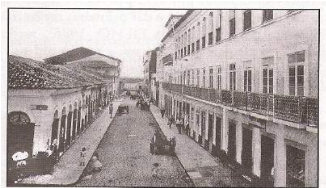
Figura 5 – Vista da Rua Portugal, Praia Grande, São Luís: conjunto de sobrado e azulejados, consequência da verticalização provocada pela valorização do solo
