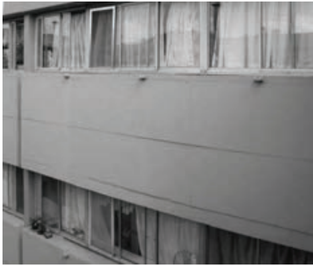
Figura 20. Carpintería de aluminio y marcas de los moldes
