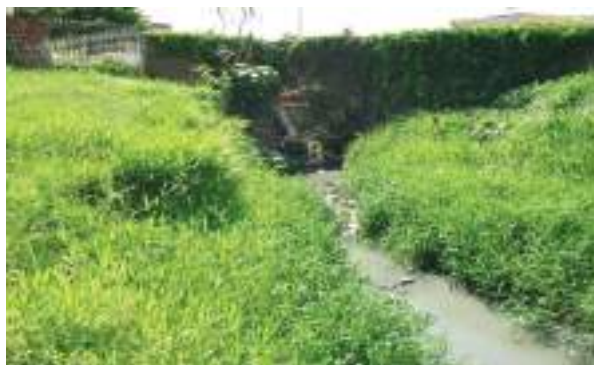
FIGURA 1: Despejo de águas residuárias no interior do reservatório
